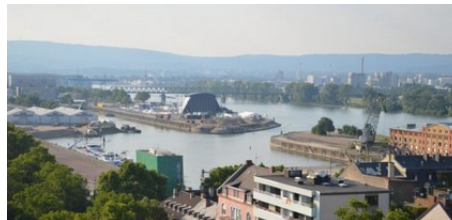
Waren Grundstücksverkäufe im Zollhafen Mainz illegal? (Foto: gik)
