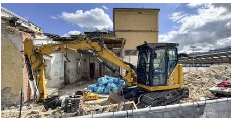
So geht es mit dem Abriss am Mainzer Hauptbahnhof weiter (AZplus) (Foto: Sascha Kopp)
