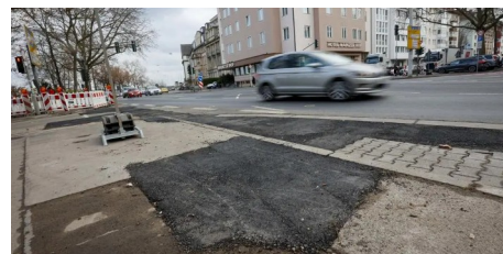
Baustelle in der Rheinallee rückt zur Kaiserstraße vor (Foto: Sascha Kopp)
