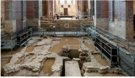
Statische Sicherung und archäologische Grabungen im Alten Dom St. Johannis vorerst abgeschlossen (Foto: Gerhard Fleischer)
