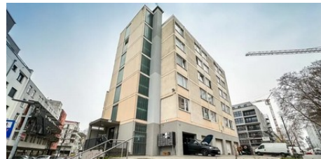
Wallaustraße 101: Renoviert wird, aber das Elend bleibt (AZplus) (Foto: Lukas Görlach)
