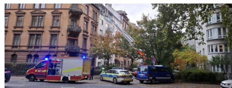
Trümmer fallen in der der Adam-Karrillon-Straße von Wohnhaus auf Straße (Foto: Ralf Keinath)
