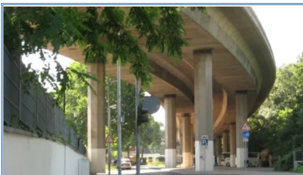
Vorbereitende Tätigkeiten zum Rückbau der Hochbrücke laufen an (Foto: Landeshauptstadt Mainz)
