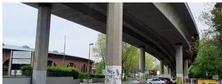
Mega-Abriss in Mainz: So soll die Hochbrücke verschwinden (Foto: Matthias Weis)
