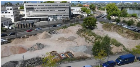
Bau der Sporthalle am Zollhafen verzögert sich (AZplus) (Foto: Kristina Schäfer)
