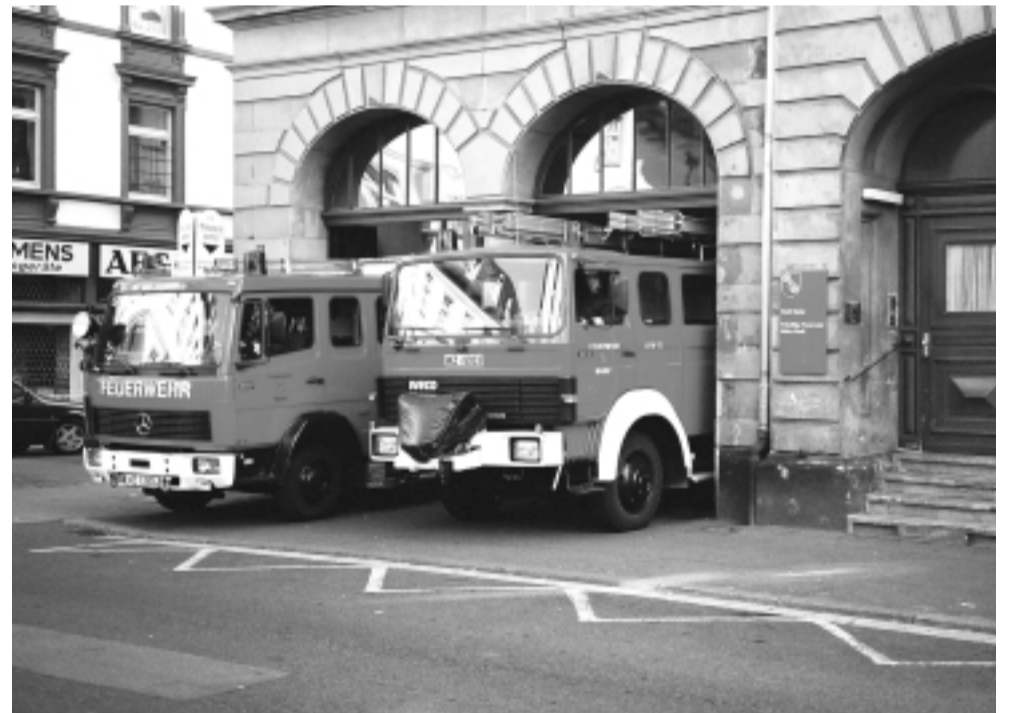
Das Gerätehaus in der Neubrunnenstraße
