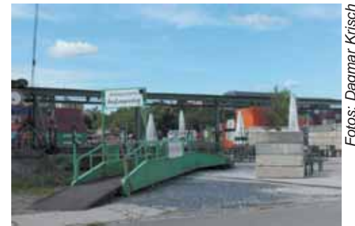
Schirme zu und Licht aus – der Biergarten muss den Bauarbeiten weichen.
