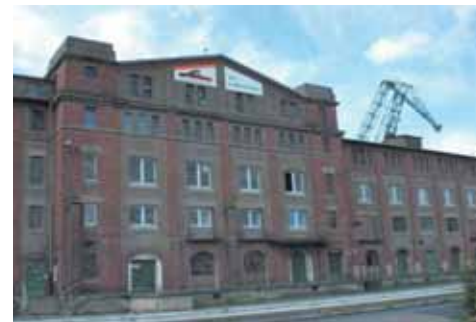
Die Revisionshalle 6 wird bald in neuem Glanz erstrahlen.
